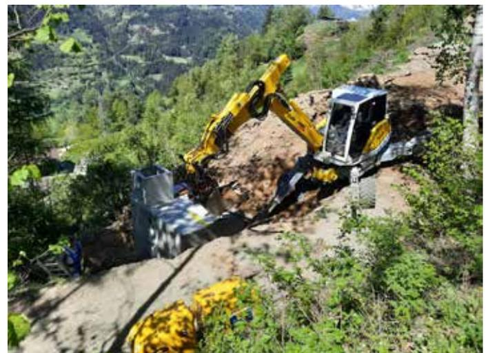
Einbau der Druckreduzierstation im Bereich des Gwabler Kirchls für die Wasserversorgung am Berg.
