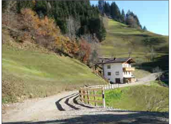
*Bewehrte Erdpackungen mit bergseitigen Drainagen und einer zeitgemäß dimensionierten Tragschicht bilden den stabilen Wegkörper der erneuerten Weganlage.*
