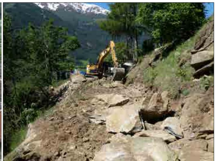
*Abschnittsweise gänzlich neu aufgebauter Wegkörper mit örtlichen Mauersteinen.*
