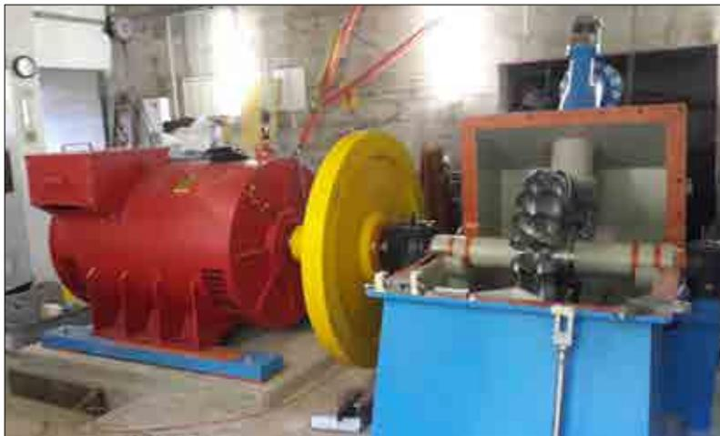
*Eine neue Turbine samt neuer Anlagensteuerung wurde im Kraftwerk Daberbach installiert und die Druckrohrleitung und der Generator generalsaniert.*
