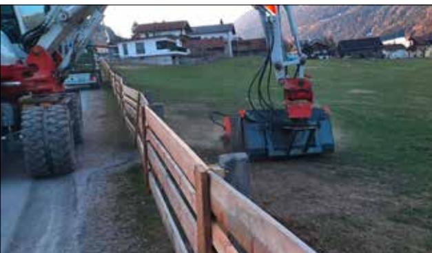
Mit schwerem Gerät werden die Splittmengen so gut wie möglich aus den angrenzenden Feldern entfernt.
