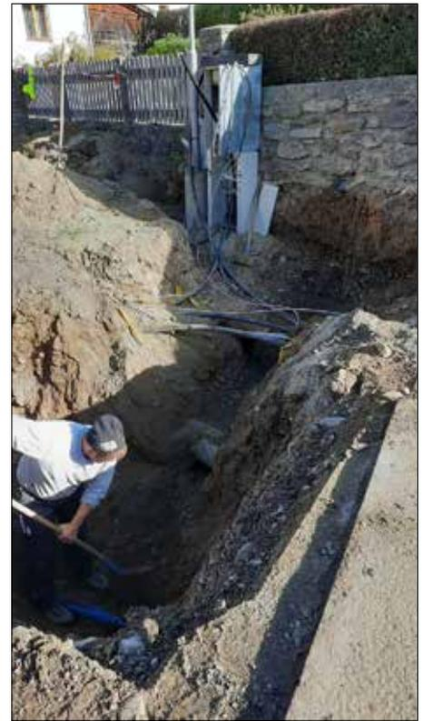
*Im Zuge der Grabungsarbeiten für die neuen Stromkabel wird auch der Breitbandausbau fortgesetzt.*
