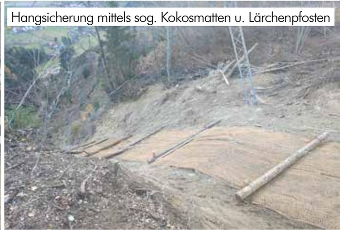
Hangsicherung mittels sog. Kokosmatten u. Lärchenpfosten
